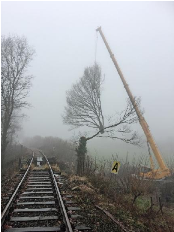
Aufwändige Baumfällarbeiten an der Brücke „Zwischen den Wellen“ bei Bad Iburg.
