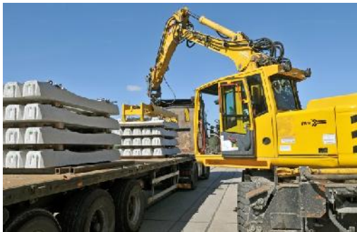
Entladung der Betonschwellen in Ibbenbüren Dörenthe
