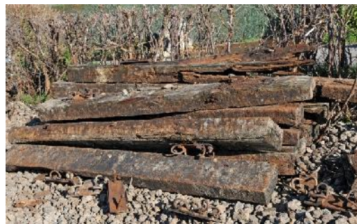
Für den Eisenbahnbetrieb nicht mehr zu gebrauchen.
