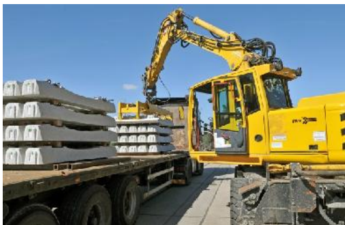
Entladung der Betonschwellen in Ibbenbüren Dörenthe
