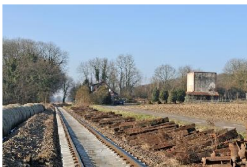
Rund eine Tonne Schotter wird pro Meter Gleis benötigt.
