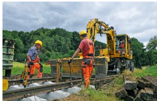
Schwellenwechsel im Bocketal nahe der Stärkefabrik Kröner
