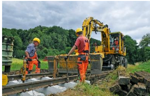
Schwellenwechsel im Bocketal nahe der Stärkefabrik Kröner
